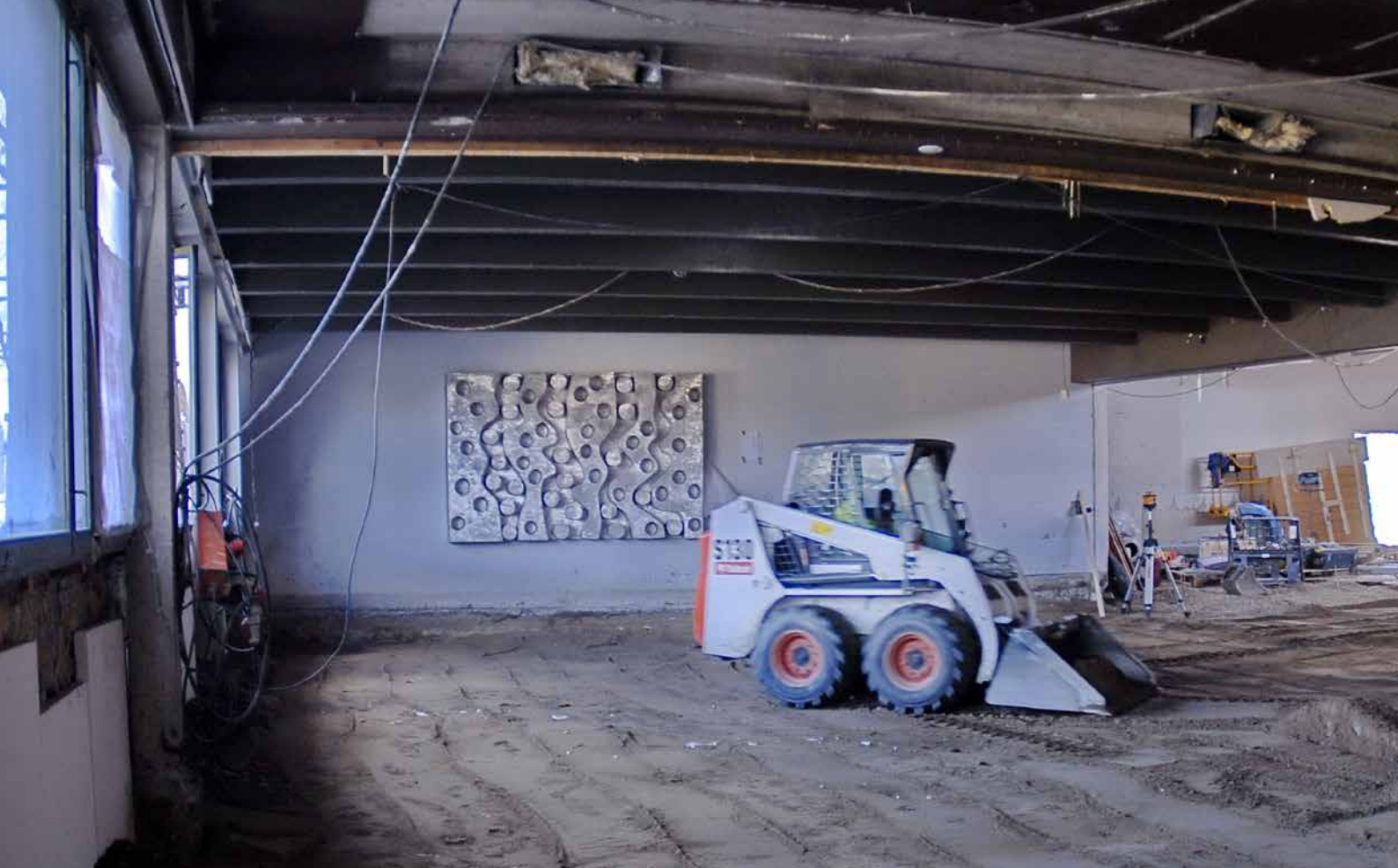
Sadoille maaninkalaisille koululaisille tuttu ruokalan seinäreliefi oli kantavien seinien ohella ainoa peruskorjauksessa jäljelle jäänyt osa nykyistä Maaninkajärven koulua.
