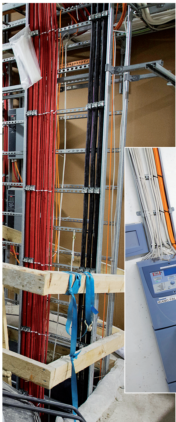
Mikko Rantala asentaa kaapelihyllyjä kauppakeskuksen rakennustyömaalla.
