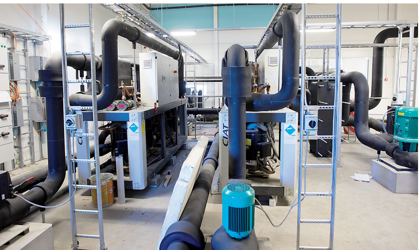
Kuvassa näkyy kauppakeskuksen jäähdytysjärjestelmä.
