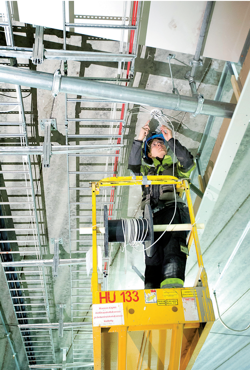
Sähköasentaja Matti Määttä ahkeroi korkeuksissa. Parhaimmillaan asentaja on ollut kolmisenkymmentä.
