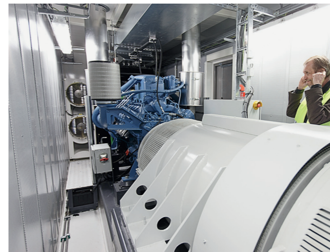
DRUPS-laitteen konehuone. Melu ei kantaudu kontista juuri ulkopuolelle hyvän eristyksen vuoksi.
