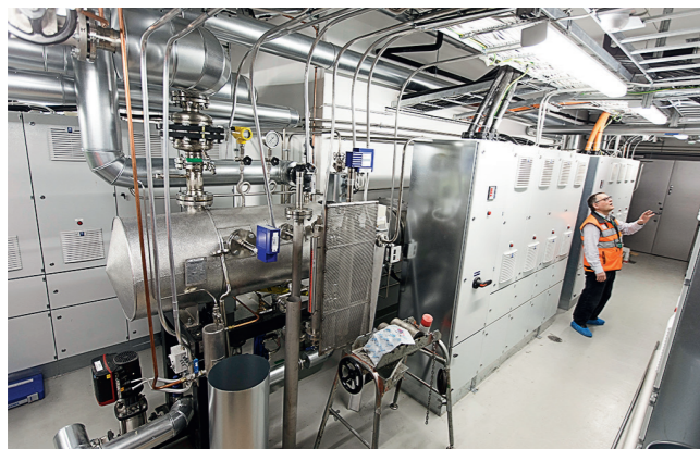
Sairaalan höyrykehityksen sähköteho on 1,5 MW ja kehittämiä on viisi.
