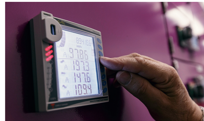
Pää- ja nousukeskukset on varustettu verkkoanalysointilaitteilla, jotka on liitetty sähköverkon hallinta- ja energiamittausjärjestelmään.
