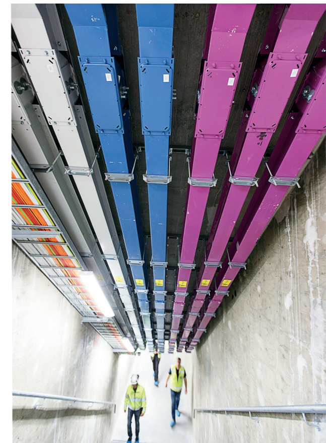
Pääsähkönjakelussa on käytetty virtakiskoja. Virtakiskot on maalattu järjestelmän väreihin.
