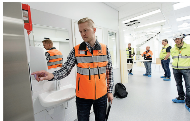
Ryhmäpäällikkö Jukka Kolehmainen säättää tehohoituhuoneen valaistusta KNX-kosketusnäyttöltä.
