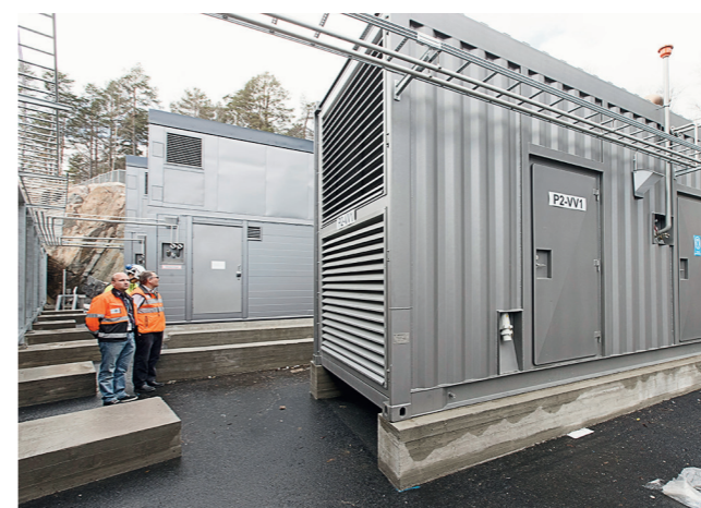
DRUPS- ja varavoimalaitteistot on sijoitettu kontteihin.
