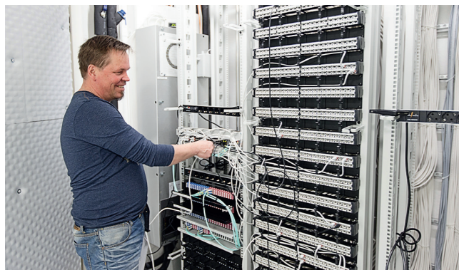
Asentaja kytkee yleiskaapelointipisteitä käyttöön. Kaarisairaalan yleiskaapelointipisteiden määrä on todella suuri.
