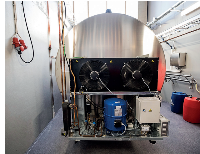
Maitotankin 37-asteinen lämpö hyödynnetään eläinten juomaveden lämmittämisessä.
