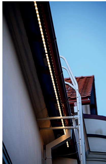
Räystäälle sadevesikourujen taakse laitetuilla ledivalaisimilla rakennettiin valopesu, jolla koko kirkkorakennus valaistetaan ympäriinsä tasaisesti, mutta himmeästi.
