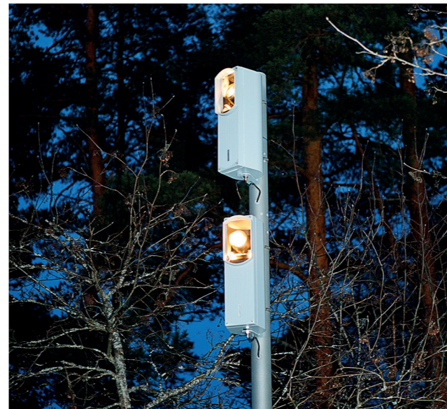
Projektoriheittimen ansiosta valo pystytään rajaamaan tarkasti pääjulkisivuun. Kun valo rasteroidaan oven kohdalta, ei heittimen valo valaise ovea, vaan ainoastaan pääsisäänkäynnin julkisivuosuutta. Kaarevaa osaa korostettiin vielä lisäämällä erillisiä valaisimia luomaan kontrastia muun julkisivun kanssa.
