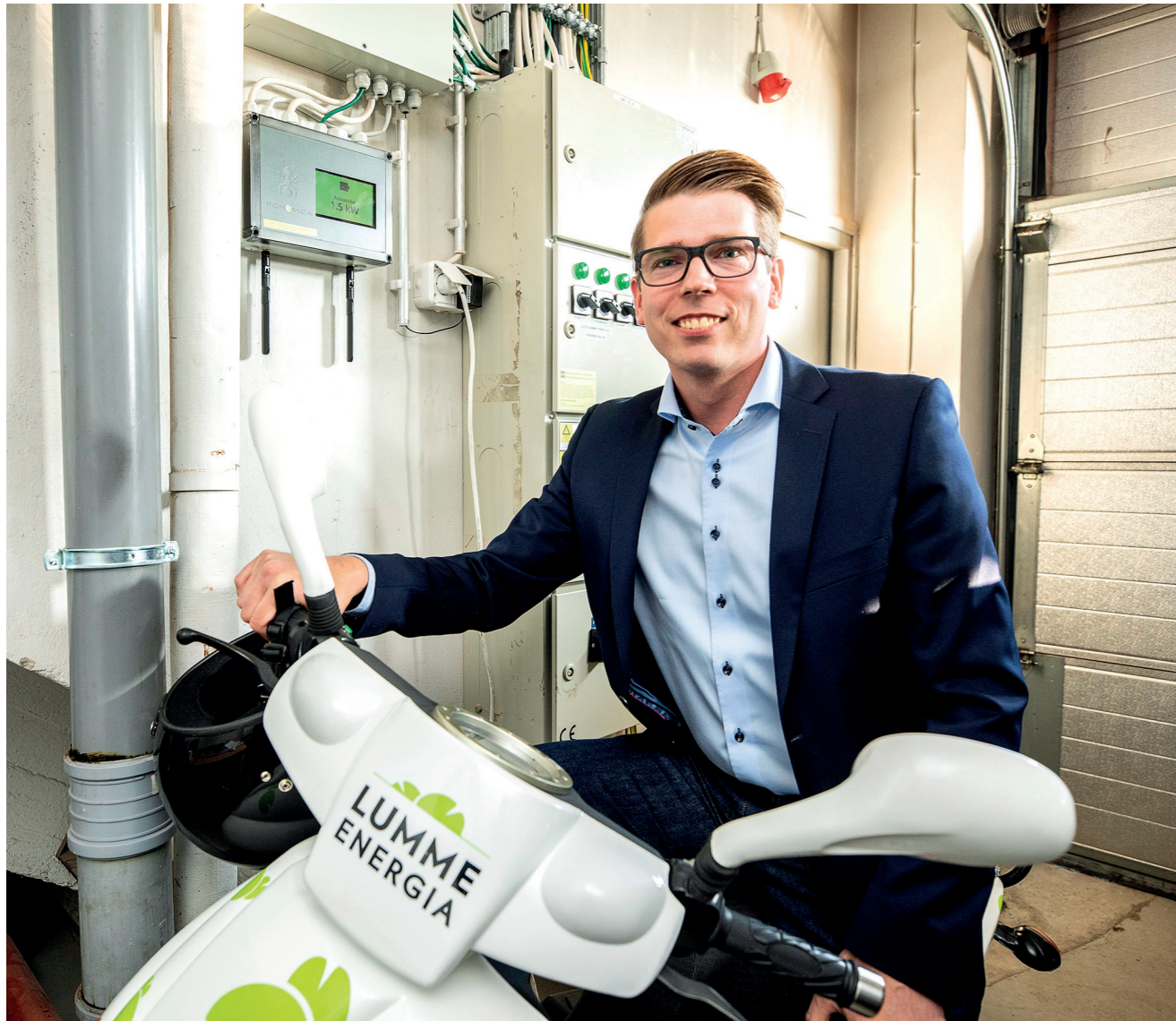
Lumme Energian henkilöstöllä on käytössään myös sähkömopo, ohjaimissa Toni Hannula. Taustalla seinällä Foremica jakamassa akkuvarastoon kerättyä uusiutuvaa sähköä.
