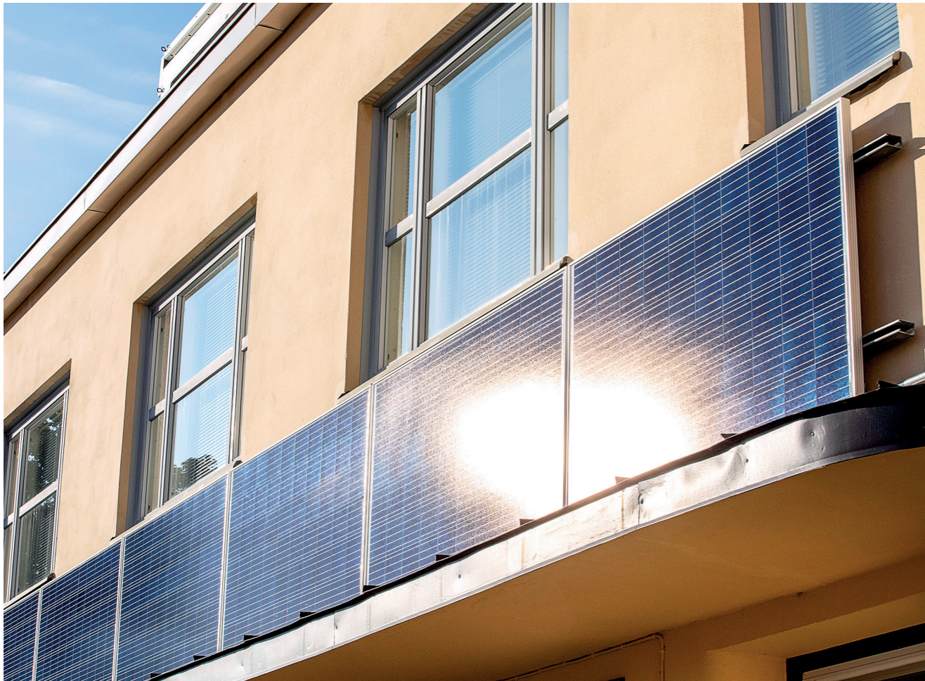
Aurinkopaneelit kiertävät Lumme Energian julkisivua, yhtenä osana virtuaalivoimalaitosta.
