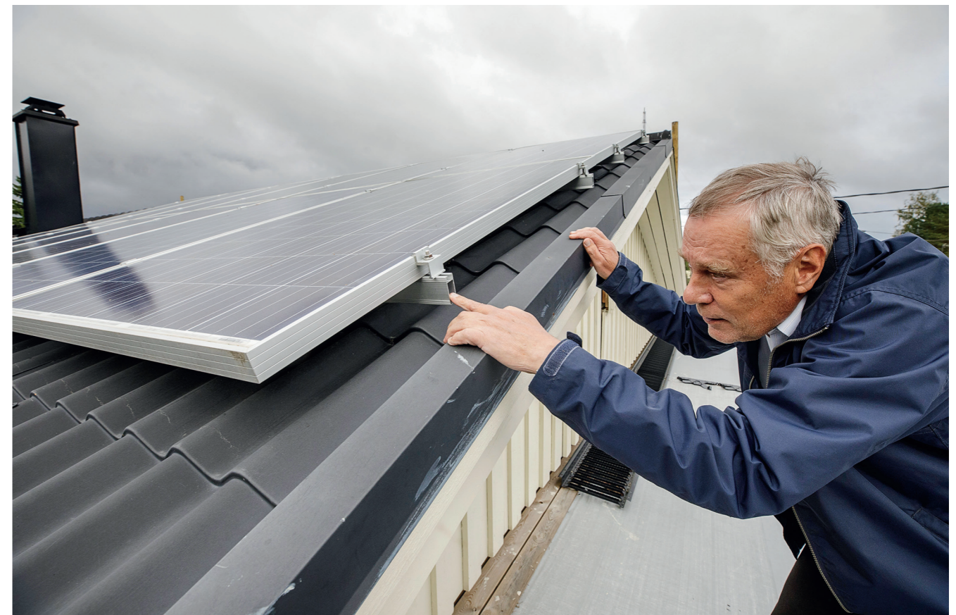
Huipputeho eli runsaat 3 kW on saavutettu aina, kun aurinko osuu kunnolla talon katolle asennettuihin paneeleihin.
