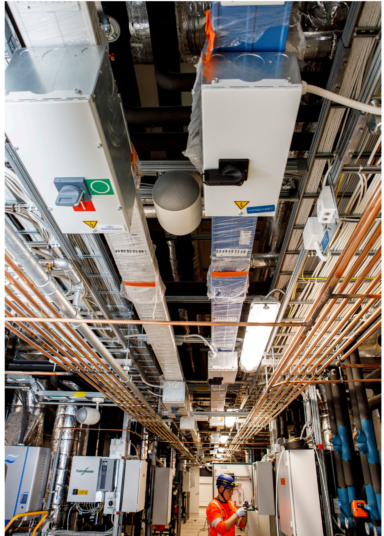
Sähkön jakelukiskot virranottimiseen IV-konehuoneessa.
