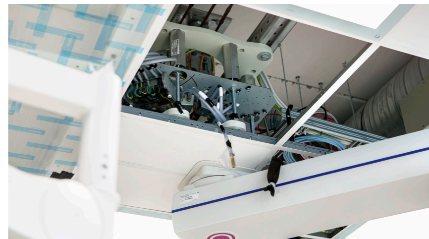
Leikkaussalin katossa on kattokeskuksen kiinnitys- ja kytkentäpaikka.
