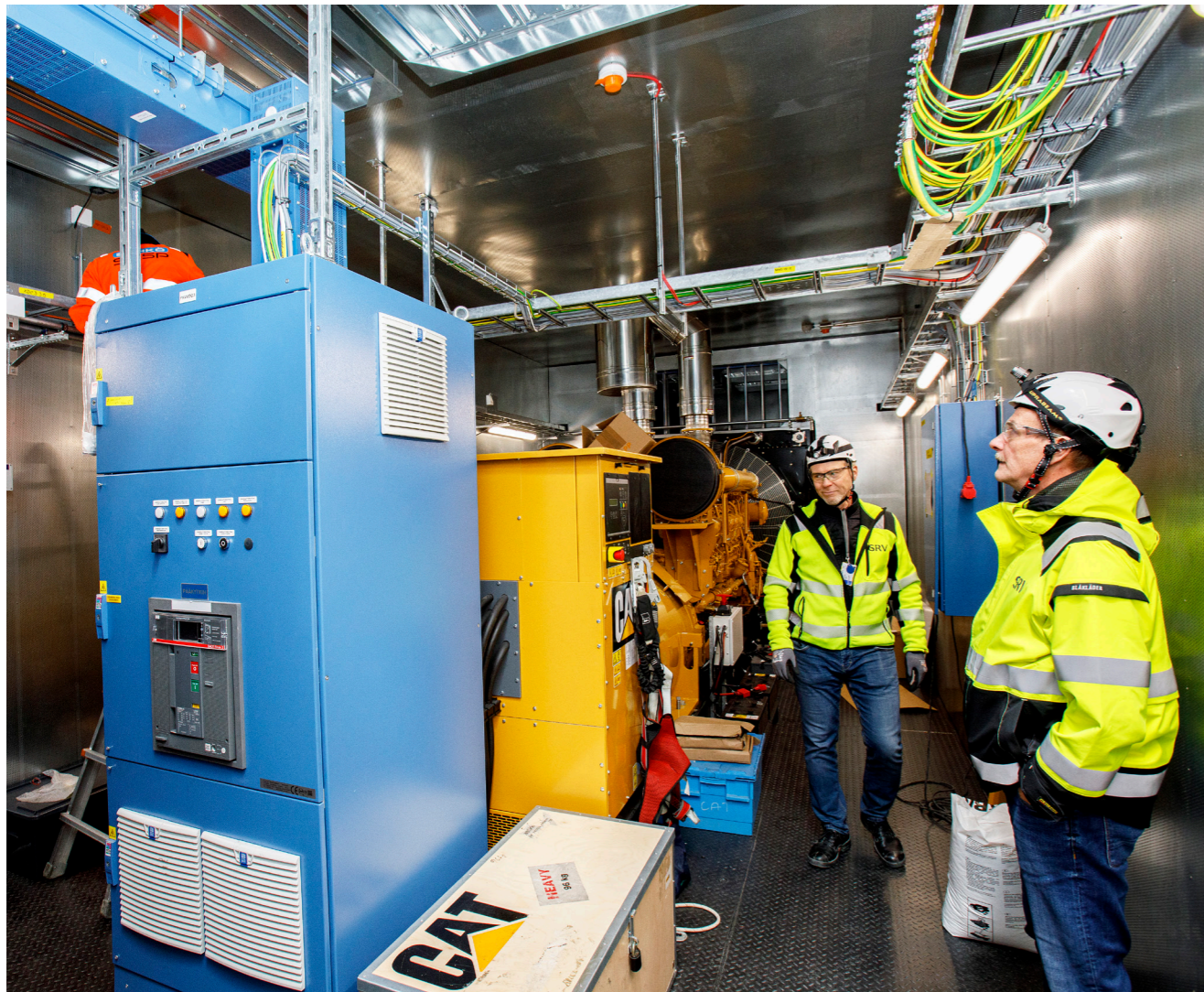
Juha Kairimo ja Kari Myllyaho (oik.) varavoimarakennuksessa, jossa on varavoimakoneita kolme kappaletta rinnakkain eri huoneissa.
