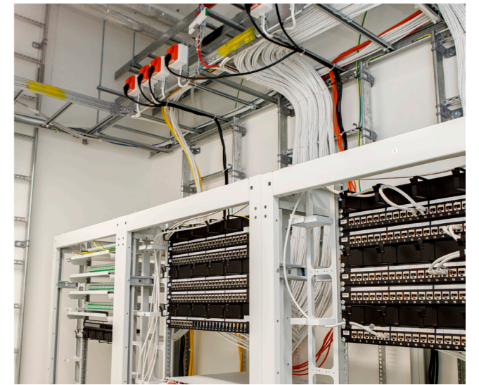
Aktiivilaitteita vailla oleva kerrosjakamo, joita on toista sataa eri puolilla sairaalaa.
