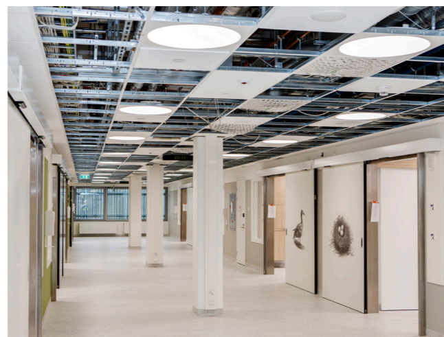
D-lohkon 5. kerros. Vastaavia lohkoja on sairaalassa 36 kappaletta. Osasto on 36 metriä pitkä ja huoneet ovat aina yhdelle hengelle.
